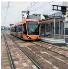
福井フェニックス通 りのedilon)(sedra フィルターブロック、 天然石による舗装軌 道の例
